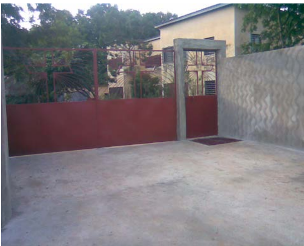
Brama wieńcząca budowę muru
